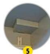
5 Větrací otvor s tavnou pojistkou
